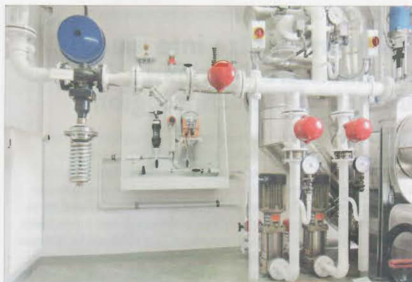
Bild 2. Das Dosiersystem mit der Magnet-Membrandosierpumpe Delta
